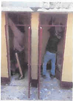
Foto 1: Sellado de grietas en el techo y fisuras en muros de los servicios sanitarios.
