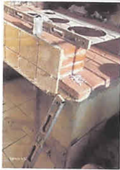
Foto 2: Sustitución de estufa rural.
