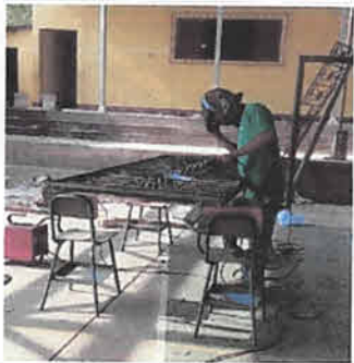
Foto 6: Fabricación de balcones de metal para las aulas 1 y 2 de la escuela.
