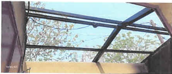
Foto 6: Desmontaje del techo de la cocina.
