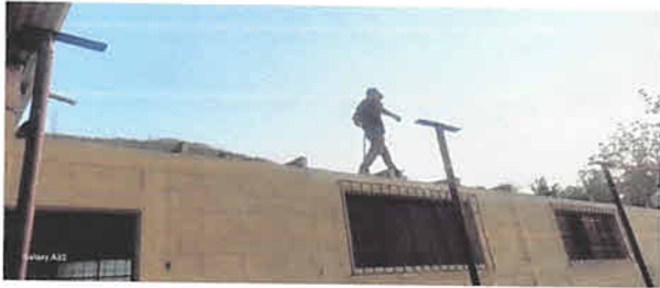
Foto 1: Desmontaje del techo de las aulas 1 y 2 y el corredor de la escuela.
